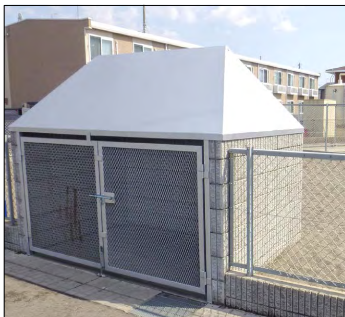
【新設されたごみステーション】
