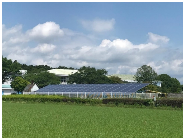
【押上小学校太陽光パネル】
