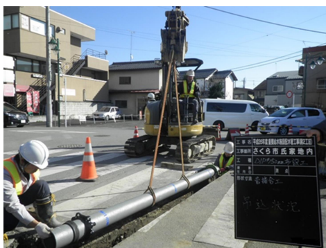
【水道管の取り替え作業】
