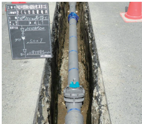
古い水道管を地震に強い水道管に取り替えている工事
