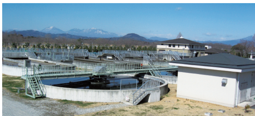
水処理センター
