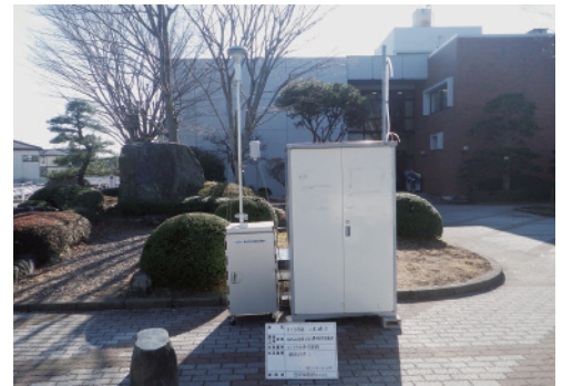
大気環境調査状況
