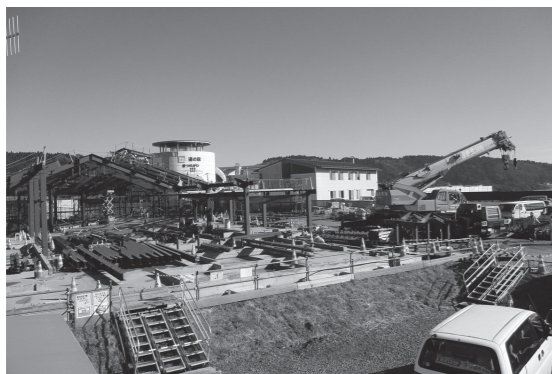
道の駅きつれがわりニューアル工事現場
