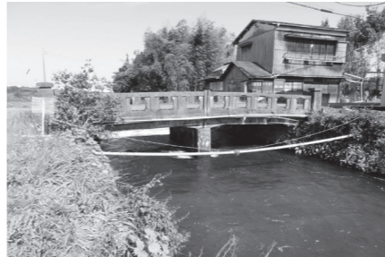
供用年数50年以上経過した「大橋」(押上)
