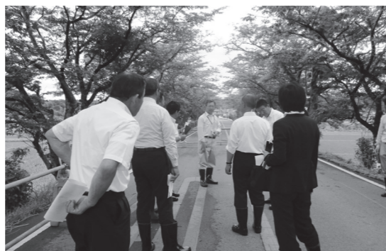
早乙女桜並木の地盤沈下箇所
