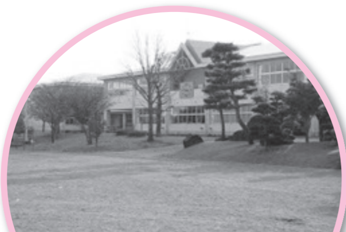
小学校施設長寿命化改良事業 (押上小学校)
