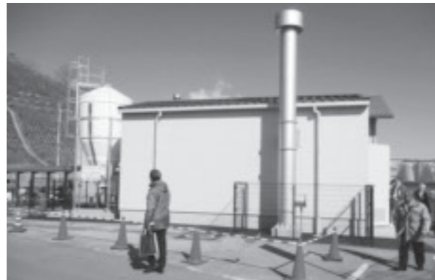
もとゆバイオマスボイラー
