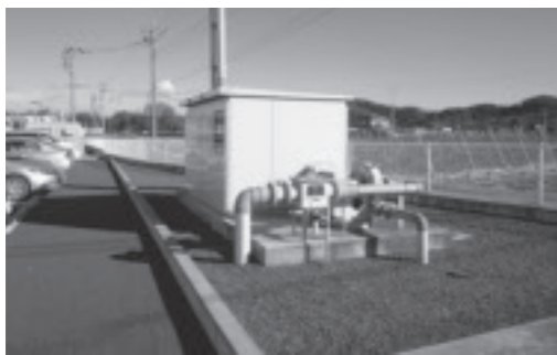
酵母処理方式汚水処理装置
