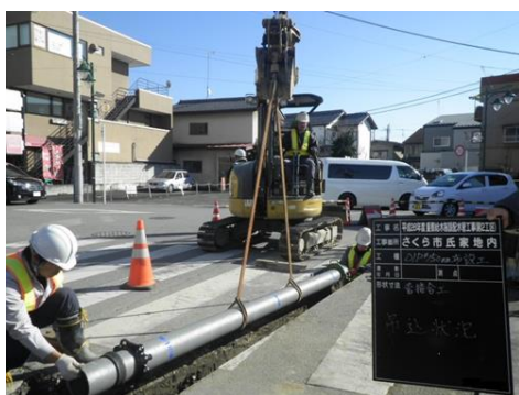
【水道管の取り替え作業】
