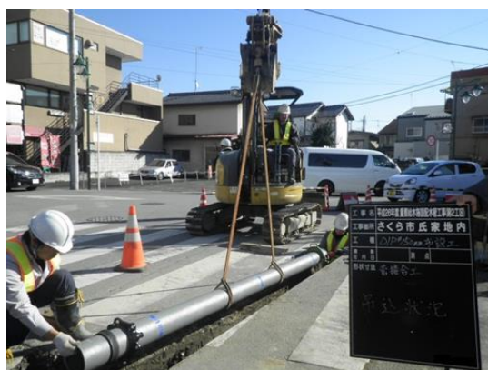
【水道管の取り替え作業】
