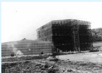
建設中のニッカウキスキー栃木工場
