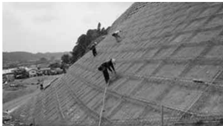
■4ブロックの法枠作業を進めています■
