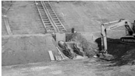
■4ブロックの法枠作業を進めています■
