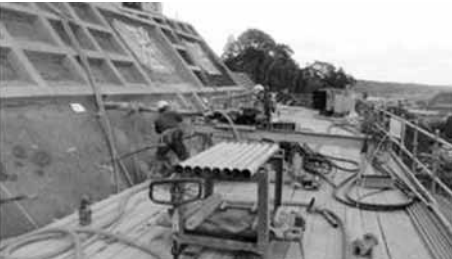
■3ブロックの法枠作業を進めています■
