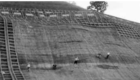
■3ブロックの法枠作業を進めています■
