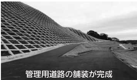
植生シートによる斜面緑化が完成
