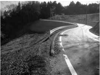
鹿子畑浄水場進入路（復旧後）
