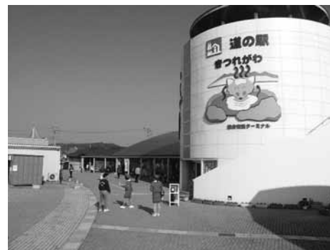
道の駅きつれがわ足湯設置工事
