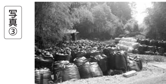
■大型土のう製作状況■
