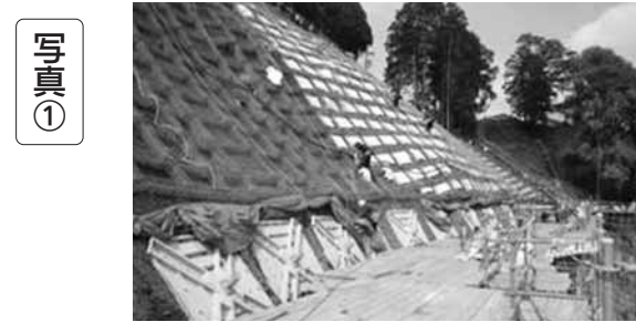
■大型土のう製作状況■
