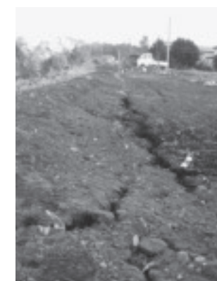
ひび割れが生じた畑
