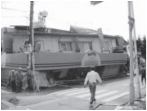
甚大な被害を出した中越地震の様子 (財団法人消防科学総合センター「災害写真データベース」より)
