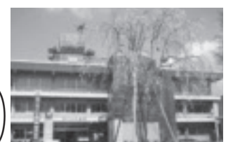
市役所本庁舎耐震補強
