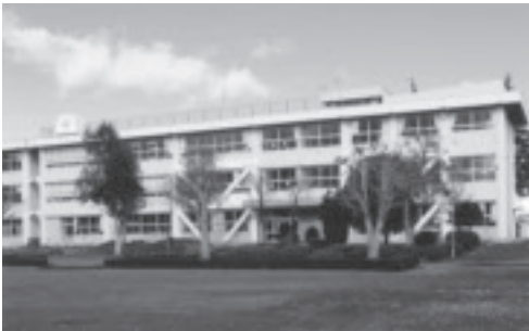
上松山小学校耐震改修事業
