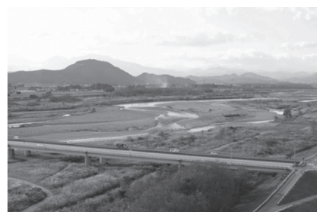
氏家大橋(昭和39年竣工)
