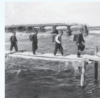
葛城大橋流出のため仮橋へ 葛城分校へ(昭和30年)
