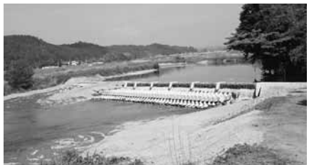
農業用施設災害復旧事業 （野辺山堰・復旧後）
