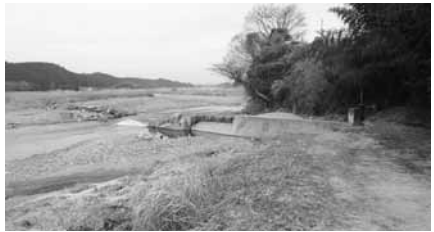
農業用施設災害復旧事業 （野辺山堰・復旧前）
