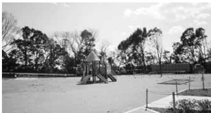
公園整備事業 （上阿久津台地街区公園5号）
