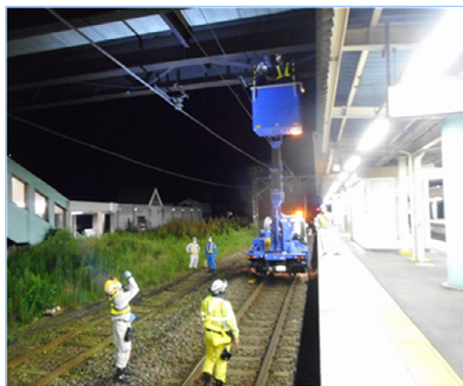
跨線橋の点検
