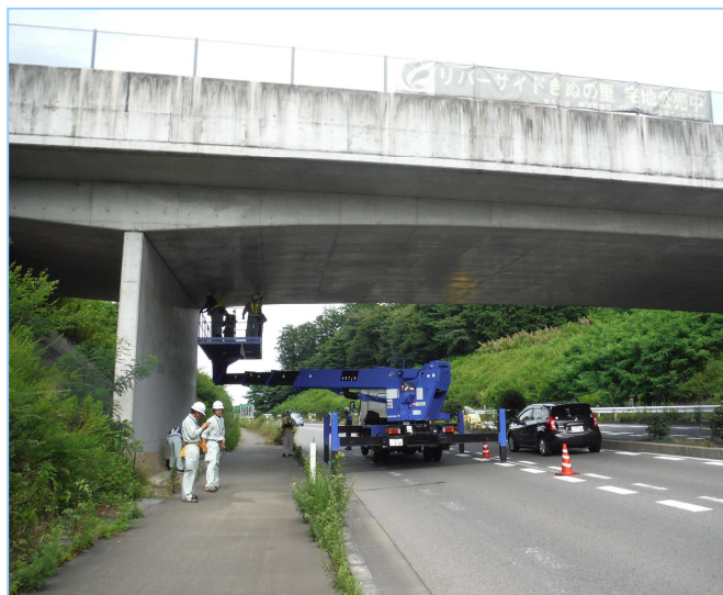
跨道橋の点検
