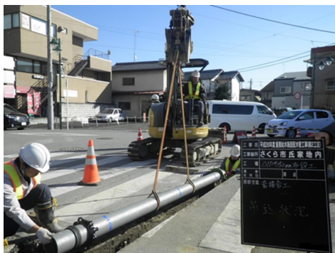
【水道管の取り替え作業】
