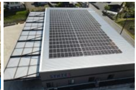
太陽光発電システム（新設工場）
