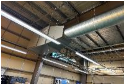
県モデル事業 オイルミスト集中局所集塵設備
