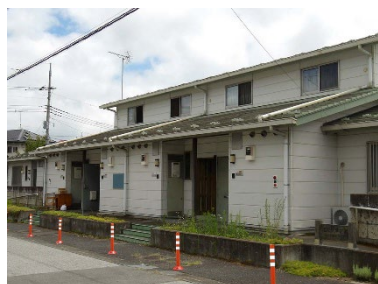
上阿久津 1号棟の外観
