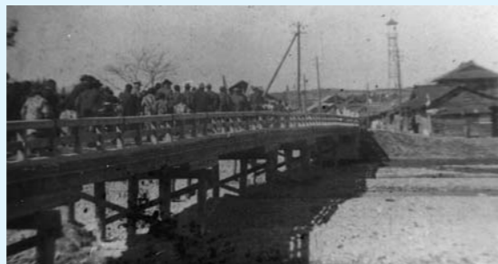
木造の連城橋(昭和15年)
