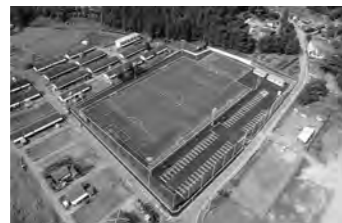
旧喜連川高校第2グラウンド整備工事
