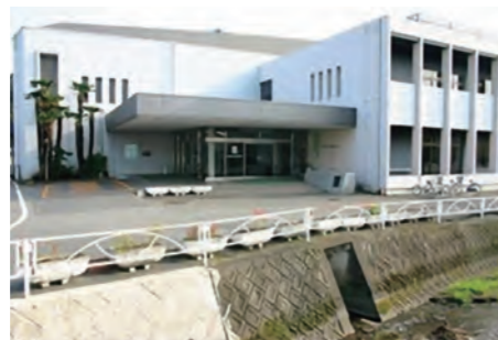
氏家公民館給排水等改修工事
