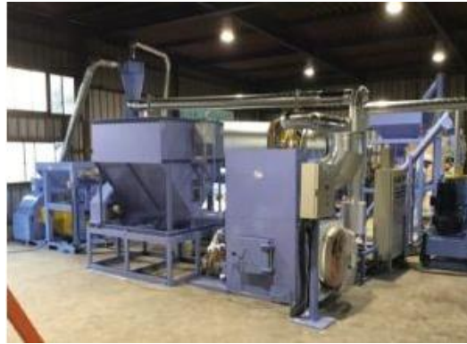
図表4-5 既存のペレット製造工場
