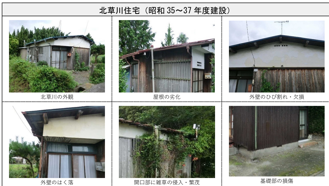
図表-30 現地調査の概要（躯体及び室内の劣化状況等の写真）
