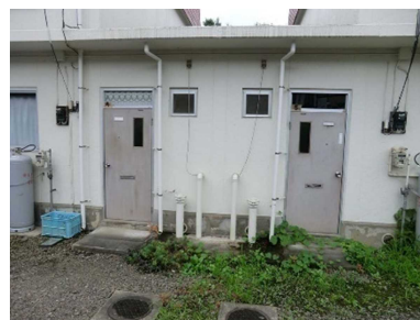
外壁・開口部
