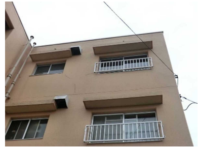
外壁・開口部
