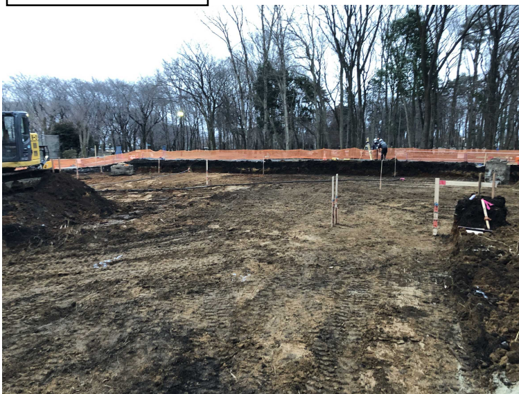
敷地造成の様子
