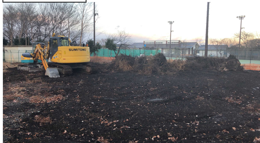
敷地造成の様子
