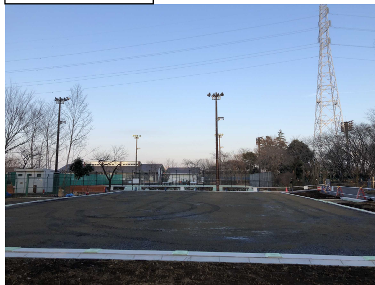
路盤敷き均し転圧
