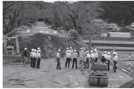
早乙女桜並木復旧工事現場
