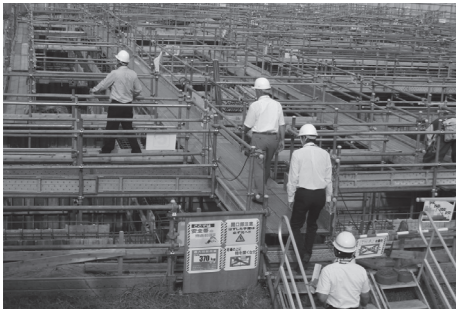
道の駅きつれがわりリニューアル工事現場
