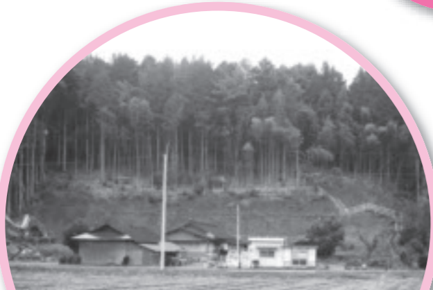
急傾斜地崩壊対策事業 (根本地区)
