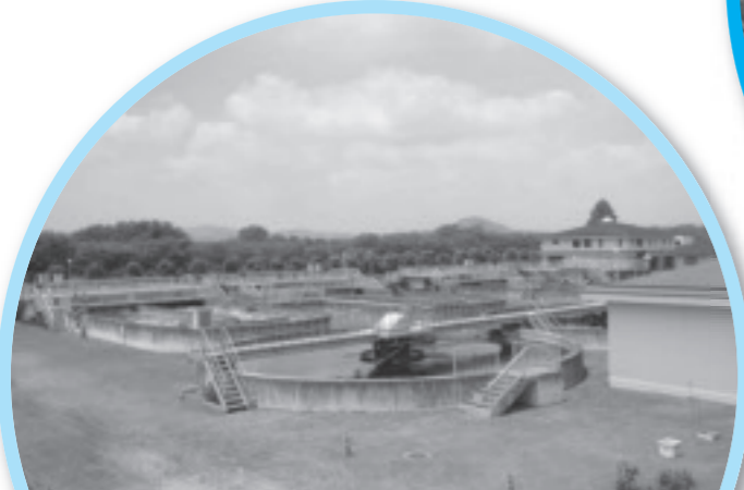
氏家水処理センター建設工事 委託に関する協定契約 2億4,100万円
