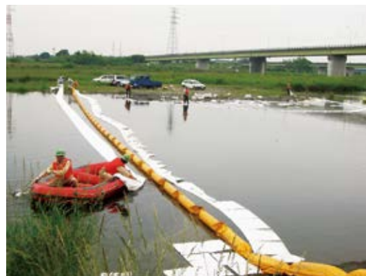
油除去作業の様子（オイルフェンス設置）
