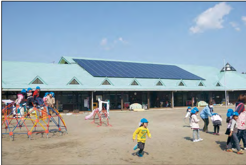
【たいよう保育園に設置した太陽光発電パネル】
