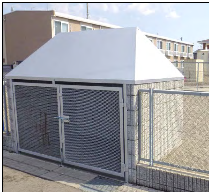
【新設されたごみステーション】
