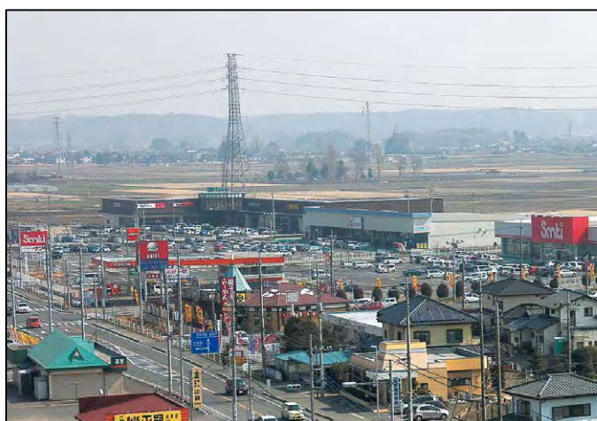
【国道 293 号沿いの商業施設】
