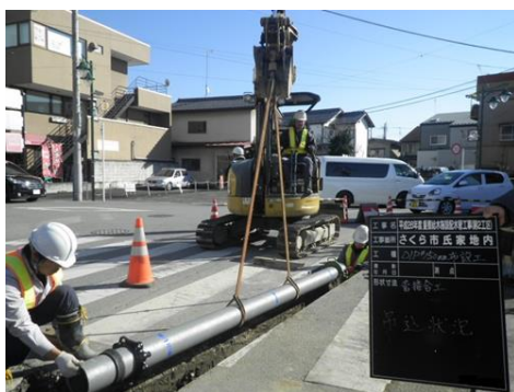
【水道管の取り替え作業】
