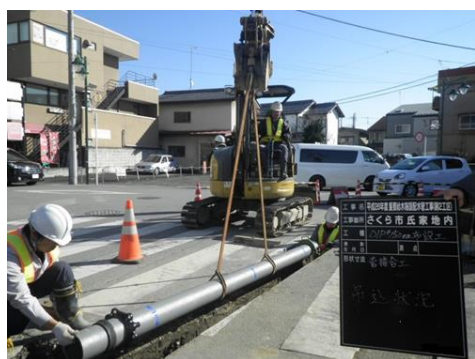
【水道管の取り替え作業】
