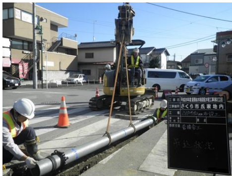
【水道管の取り替え作業】
