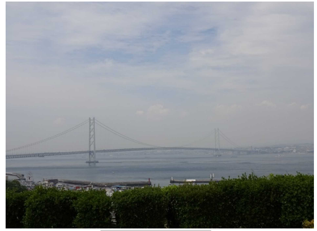
明石海峡大橋
