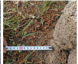
地面に散らばったフラス 上部の枝からフラスが排出されている場合もある
