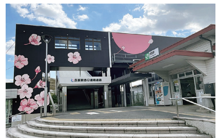
氏家駅東西線修繕工事
