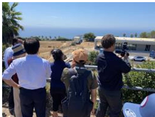
大規模改修工事中のパーク
