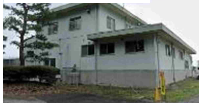
②南小学校プール棟
